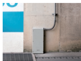
電極式水位検知器
